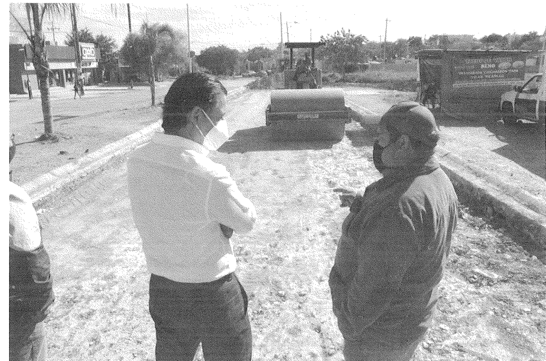
El alcalde Lic. Gerardo Benavides Villarreal supervisó la rehabilitación de pavimento en la Colonia Lomas.
